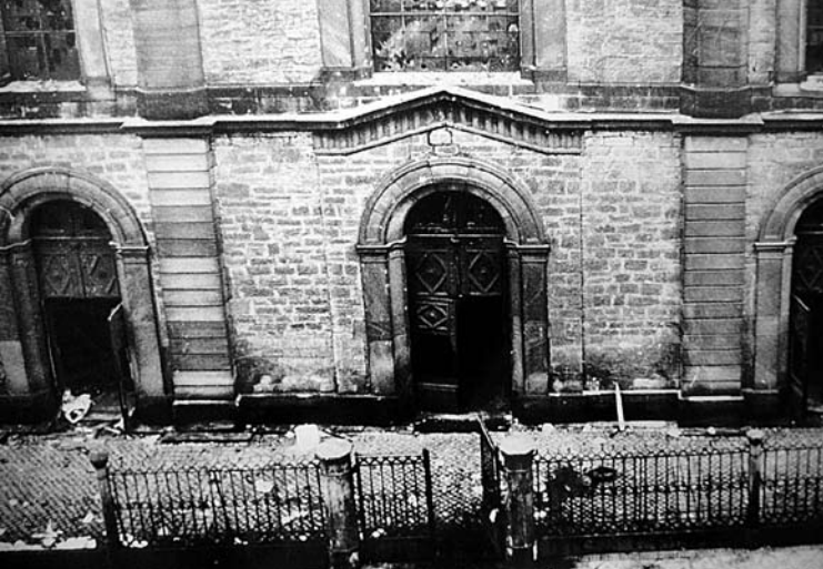
8.11.1938. Zerstörter Eingangsbereich der Großen Synagoge
